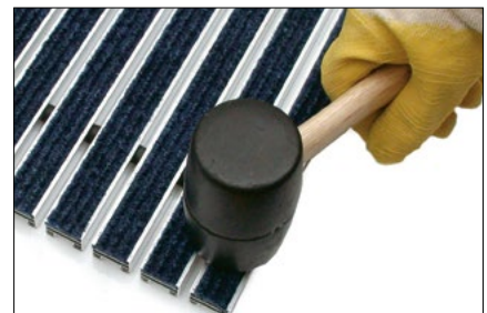
Neue Ripsstreifen mit Selbstklebeband in das Aluprofil einkleben und ggf. mit einem Gummihammer den Klebeprozess verstärken.
